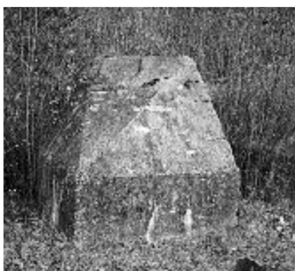
Elementi dell'ostacolo anticarro terreno Elemente der Gelände-Panzerhindernisse
