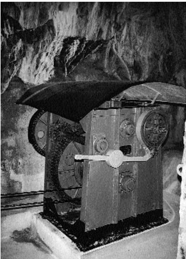
Ansicht auf die Hebevorrichtung (links Winkelkran und rechts Riemenscheibe)
