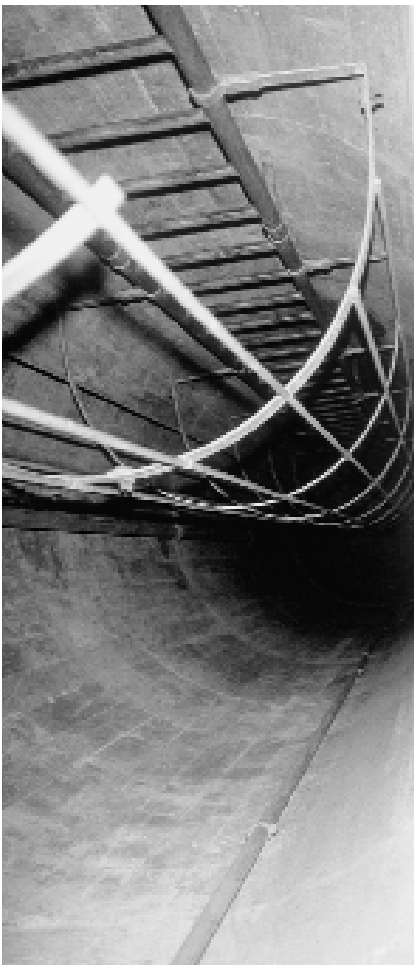
En haut à gauche: puit de la sortie de secours de l'ouvrage du Chételat En haut à droite: entrée de l'ouvrage
